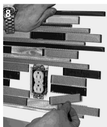
6. Une fois l'installation terminée, il peut être nécessaire d'installer une rallonge de boîte électrique (qui se trouve chez votre quincailler) autour des prises ou interrupteurs. Ceci permettra à la plaque électrique de reposer à plat contre les carreaux. **Assurez-vous que l'alimentation électrique est coupée** lorsque vous installez la rallonge de boîte électrique et suivez les instructions d'installation du fabricant ou consultez votre électricien.
